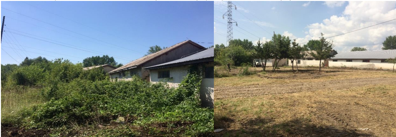
Pamje ne korrik, para dhe gjatë punimeve ne oborin e objektit te SI&MKZ
